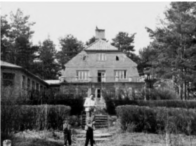
Nowy gospodarz na tle głównego budynku Stacji.
